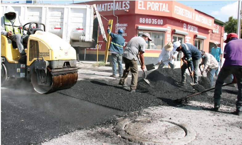
Trabajadores de Servicios Públicos realizan mejoras por todo el municipio.
